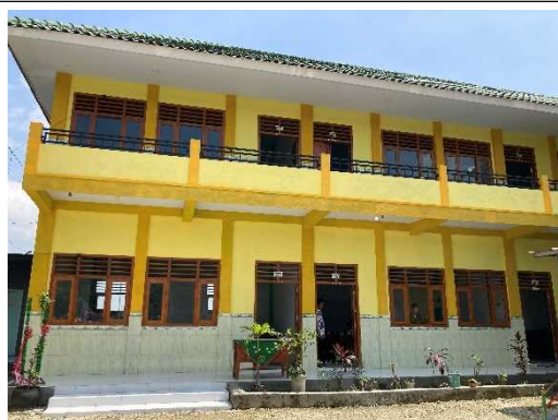
今回の支援で建設された2階建て校舎 (6教室・トイレ付き)
