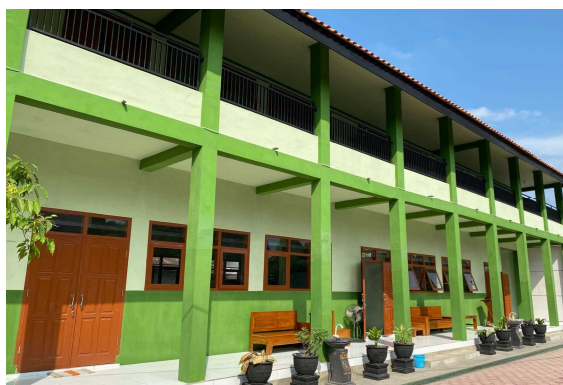
新たに建設された校舎 (2階建て、6教室)
