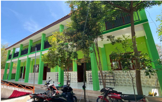
今回の支援で建設された校舎の外観
