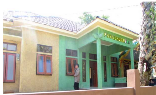
プロジェクトで建設された診療所
